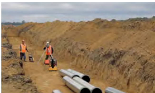
Монтаж напорного коллектора.
