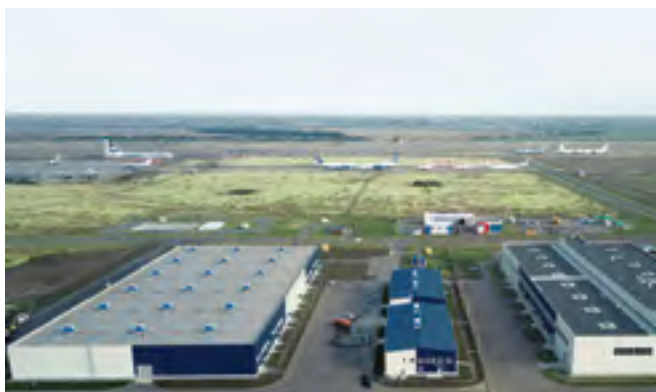
ПОЭЗ «Ульяновск–восточный» коллектор напорного трубопровода.
